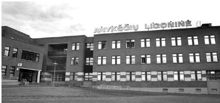
Į objektų, kuriuose bus įrengtos saulės elektrinės, sąrašą pateko ir Anykščių ligoninė.
